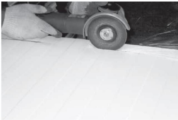
Рис №28. Запрещается выполнять резку с помощью инструментов (например, «болгарок») из-за возможного повреждения антикоррозионного покрытия
