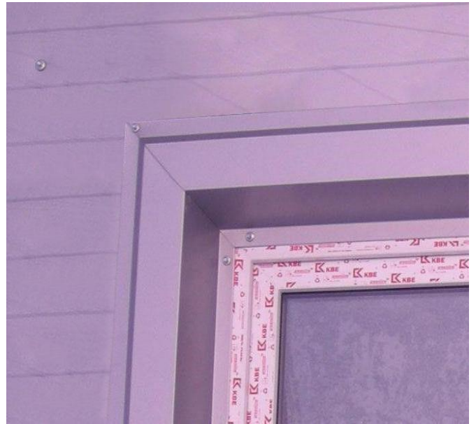
Рис. №30. Сопряжение бокового и верхнего нащельника
