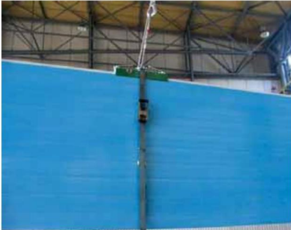
Рис. №18 Использование подъемного монтажного инструмента для сэндвич-панелей при размещении в горизонтальном положении.
